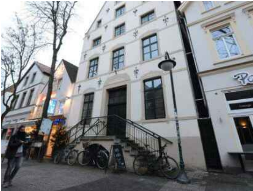
Das Gebäude „KinOLaden“ in Oldenburg ©Wikimedia Commons
