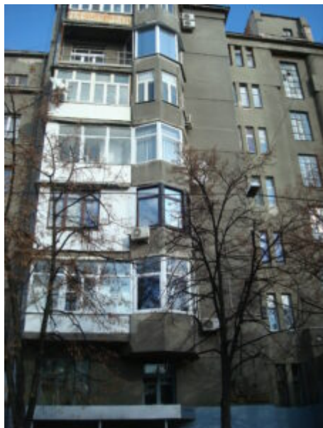
Дом 17 на ул. Гиршмана, г.Харьков
