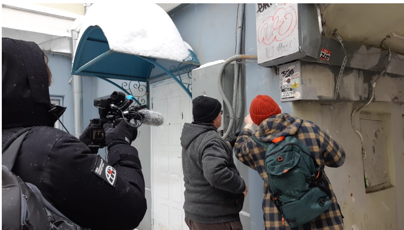
Wiederinstallation der Gedenktafel, Moskau, 10.12.2023
