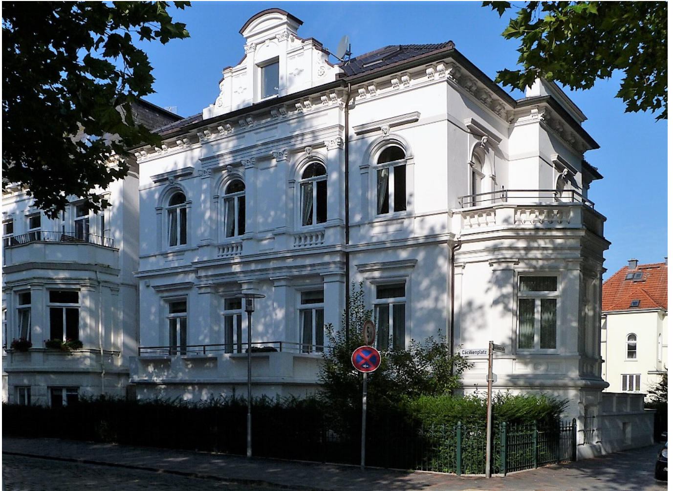
Haus in der Cäcilienstraße 9 – am Ecke des Cäcilienplatzes
