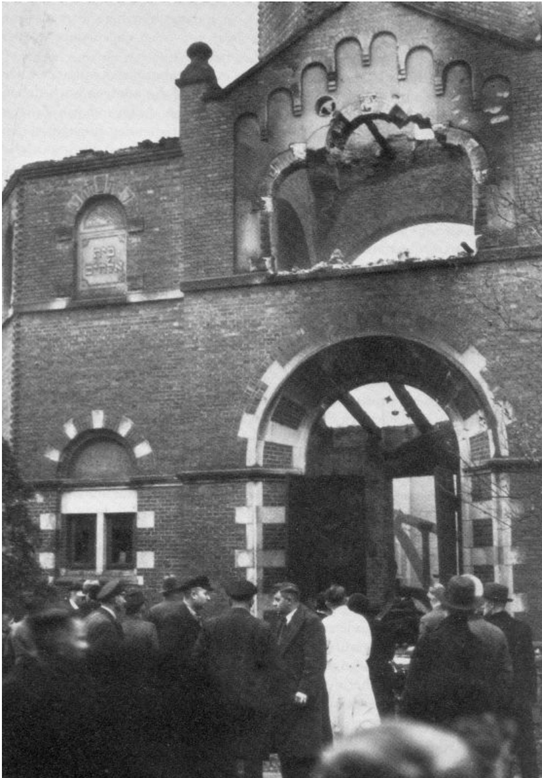
Zerstörtes Synagogengebäude, Peterstraße 2, 1938
