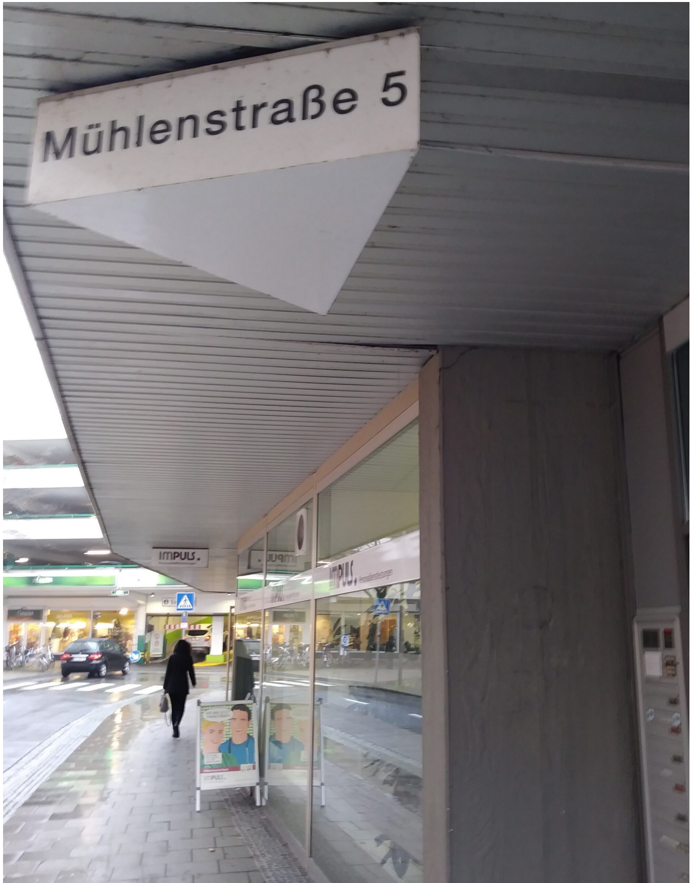
Mühlenstraße 5 – Blick von der Straße
