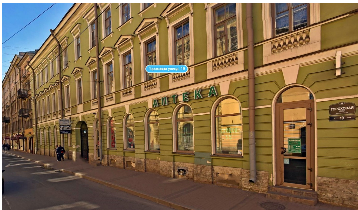
Здание на Гороховой ул. в Петербурге, где находилась частная женская гимназия Д.Т.Прокофьевой, современное фото
