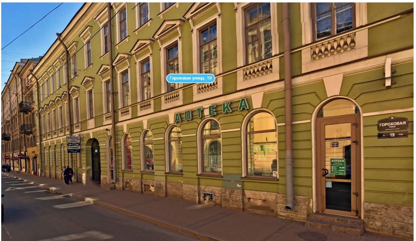
Das Gebäude in der Gorokhovaya-Straße in St. Petersburg, in dem sich D. T. Prokofievas privates Mädchengymnasium befand, modernes Foto
